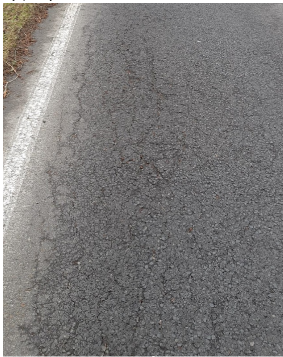
Síťové trhliny
