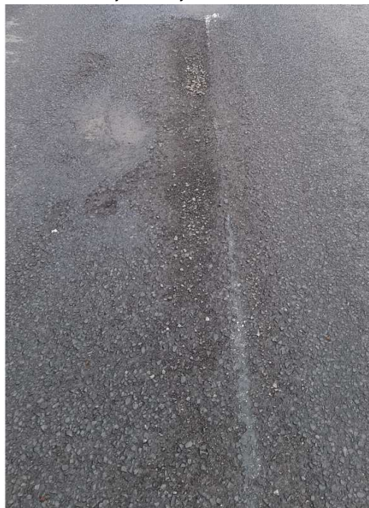
Ztráta asfaltového tmelu, výtluk
